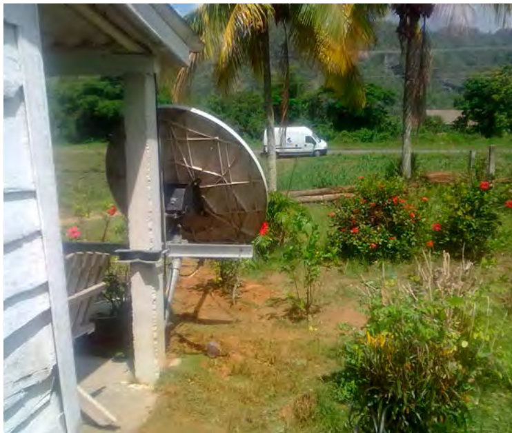
2006 Los servicios de red IP —Internet Protocol— para voz y datos por acceso satelital VSAT —Very Small Aperture Terminal— se extienden a las zonas más apartadas, demostrando su utilidad en situaciones de desastres naturales.
