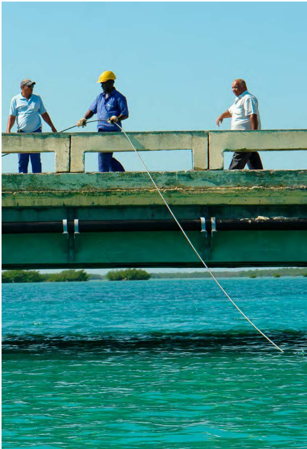
2014 Instalación del cable submarino en Cayo Coco.
